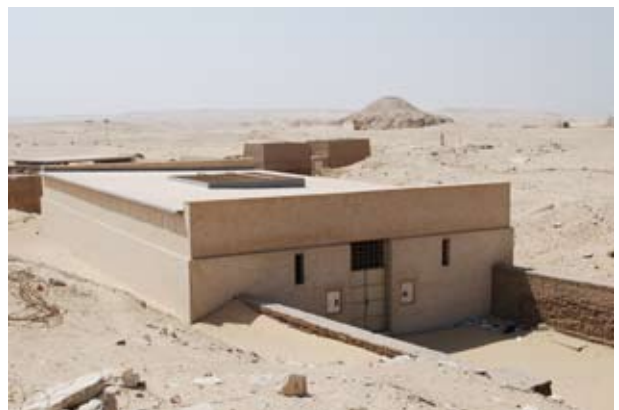
遺跡整備の現状（ホルエムヘブ墓および周辺）
